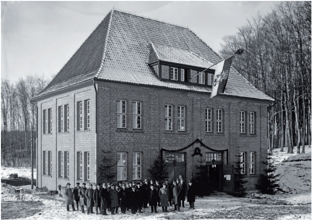
Abb. 1: Eröffnungsfeier des Schaalseekraftwerkes 1925
