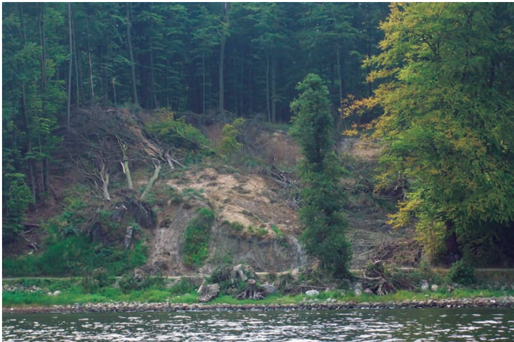
Abb. 1: Die Rutschung zwischen Wassersleben und dem Flensburger Ostseebad an der Flensburger Innenförde ist seit 2012 aktiv und verschüttet immer wieder aufs Neue den vorbeiführenden Rad- und Fußweg, der bereits mehrfach durch die Stadt Flensburg geräumt werden musste. Unterhalb einer dünnen Lage aus Geschiebedecksand befinden sich mächtige Grundmoränenablagerungen mit liegenden, vermutlich aufgeschuppten Tonen, die für die Rutschbewegung entscheidend sind (Foto: Heike Gieselmann).
